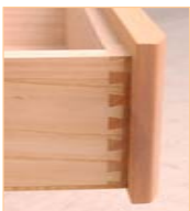
アリ組みトロ箱 強度に優れた引出しは、昔ながらの アリ組み工法で組んでいます
